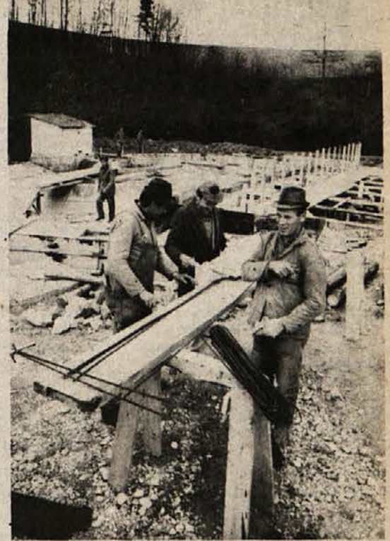
V ŠMARJETI ČISTILNI BAZEN – Kilometer pred Šmarjeto gradi Novograd po naročilu Vodnogospodarskega podjetja iz Novega mesta večjo čistilno napravo, ki bo prečiščevala kanalizacijsko vodo pred izlivom v potok Bečuj. Rok za dograditev je 20. junij letos (Foto: J. Pavlin)
