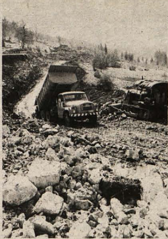
HRIB ZA BOLJŠO CESTO – Delavci Cestnega podjetja iz Novega mesta pospešeno grade cestni odsek od Dvora proti Kočevju. Nekaj asfaltne prevleke je, že položene, nadaljujejo pa z zemeljskimi deli. Pretekli četrtek so s petimi tonami razstreliva nad Laščami „umaknili“ hrib. (Foto: J. Pavlin)
