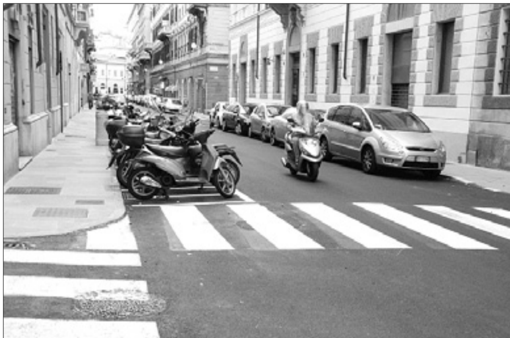
Obnovljeni pločniki in nov asfalt v Ul. Lazzaretto vecchio
