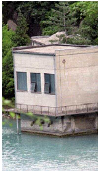
Črpalnice vodarne Mrzlek
