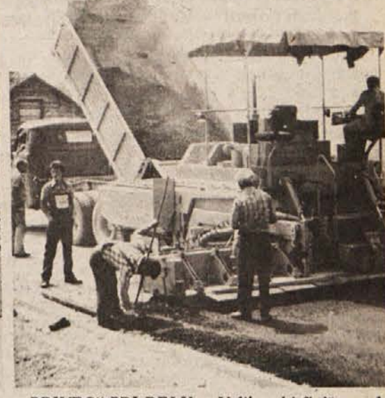
„BRIVEC“ PRI DELU – Velikanski finiše podjetja Slovenija ceste je minuli teden pričel polagati asfalt po Bruni vasi na cesti po Mirenski dolini. Naenkrat položijo vseh šest metrov vozišča, asfaltno maso pa vozijo iz svoje baze pri Ljubljani. (Foto: Železnik)
