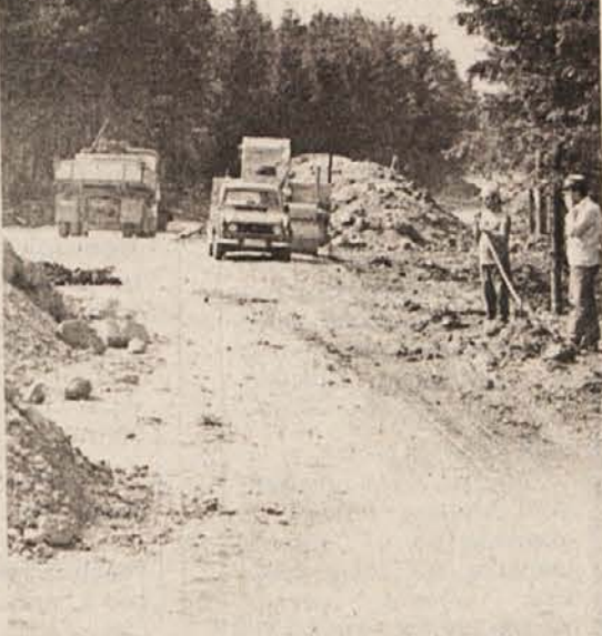
KOČEVJE BLIŽE NOVEMU MESTU – Od prejšnjega tedna je Kočevje za pet kilometrov bližje dolenski metropoli. Kočevska občina se je namreč odločila, in začela posodabljati makadamsko cesto skozi Kočevski Rog. Na sliki: delovni vrvež na kočevski cesti. (Foto: J. Pezelj)
