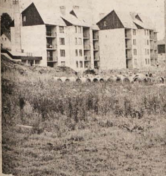
KMALU VSELJIVA – Gradbeno podjetje Pionir dokončuje gradnjo 13- in 16-stanovanjskega bloka v Straži pri Novem mestu. Oba naj bi dokončali konec tega meseca. Največ stanovanj je za delavce Novolesa, Gozdnega gospodarstva in Gorjancev. (Foto: M. Markelj)
