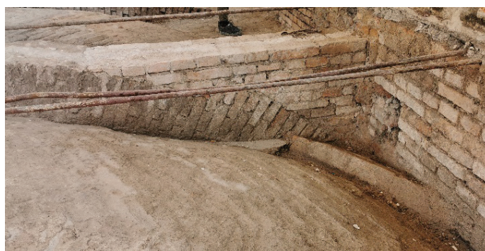
Slika 8. Jeklena natezna vez oboka (foto: arhiv Elea iC, d. o. o.).
