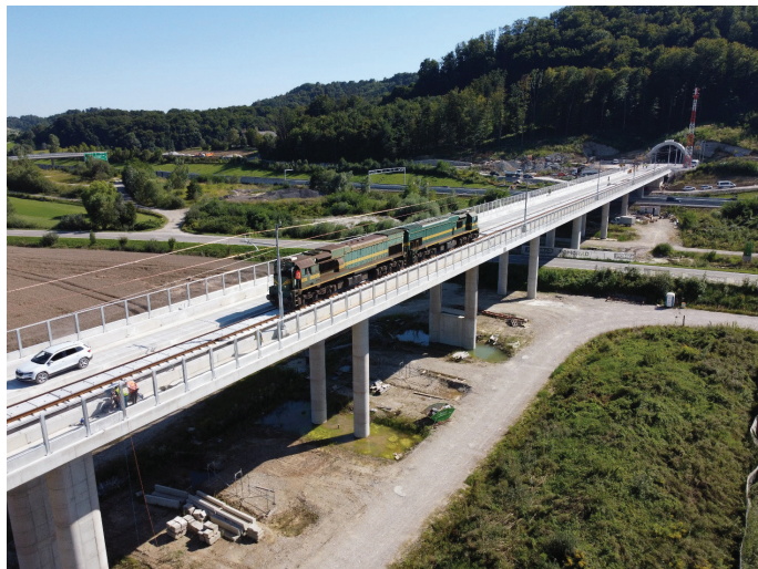
Slika 25. Obremenilna preizkušnja viadukta z dvema lokomotivama, vsaka po 110 ton mase.
