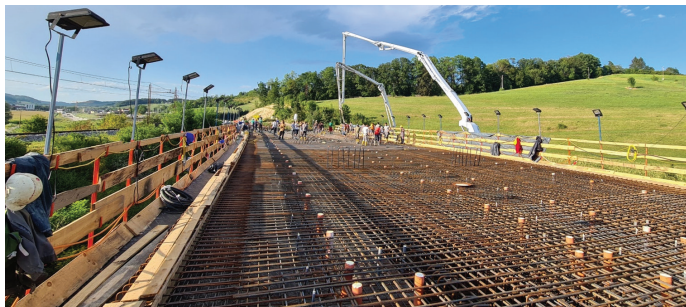
Slika 22. Priprava na betoniranje segmenta 1560 m 3 v enem taktu.
