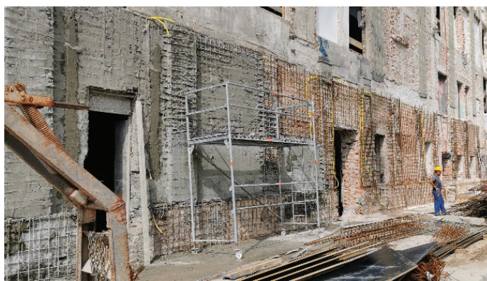
Slika 11. Ojačenje zunanjih sten z armiranim torkretom (foto: arhiv Elea iC, d. o. o.).
