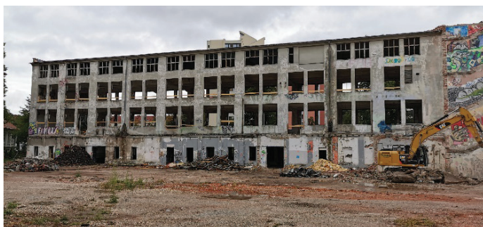
Slika 4. Pogled na objekt pred pričetkom prenove (foto: arhiv Elea iC, d. o. o.).
