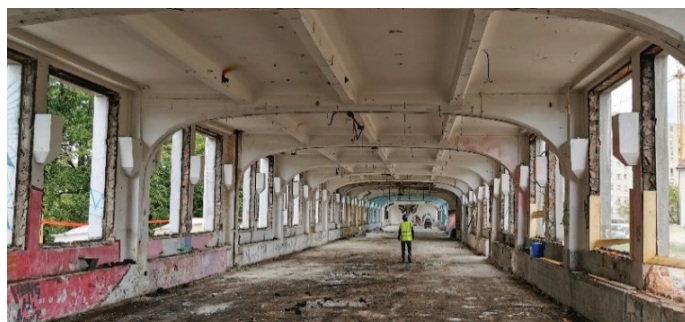
Slika 5. Notranjost objekta pred prenovo (foto: arhiv Elea iC, d. o. o.).
