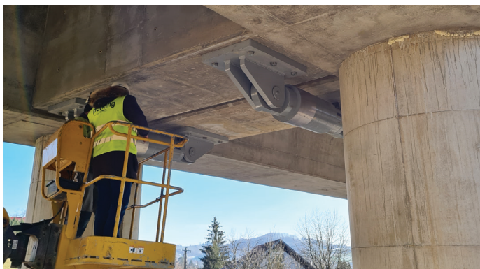
Slika 24. Hidravlični udarni blažilec (STU).
