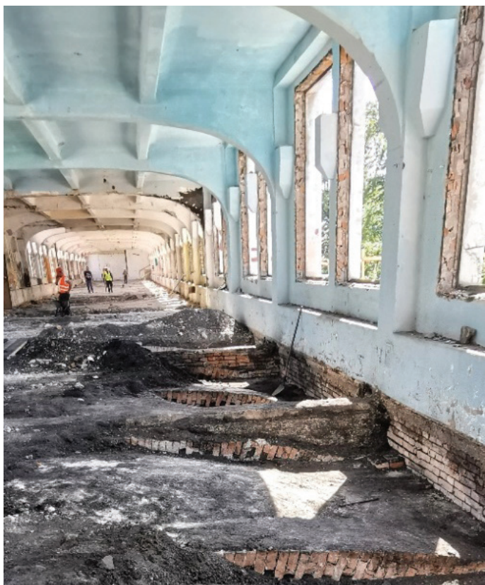
Slika 6. Čiščenje medetažne obokane konstrukcije (foto: arhiv Elea iC, d. o. o.).
