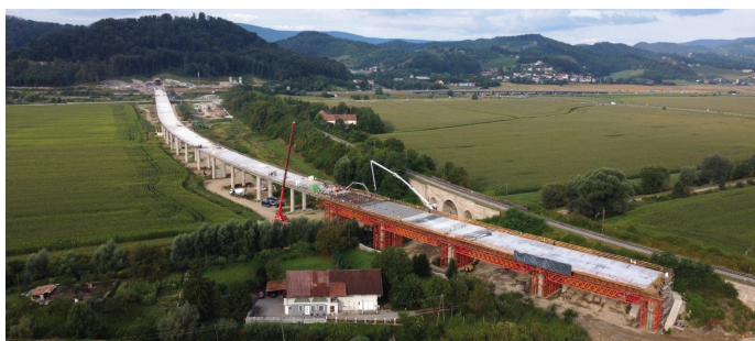
Slika 23. Zaključek betoniranja predzadnjega takta.
