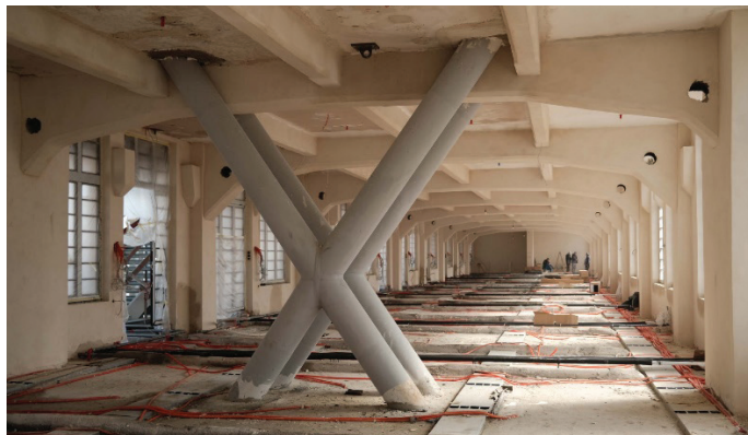
Slika 10. Vgradnja prostorskih jeklenih diagonal za izboljšanje potresne varnosti objekta (foto: arhiv Makro 5 gradnje, d. o. o.).
