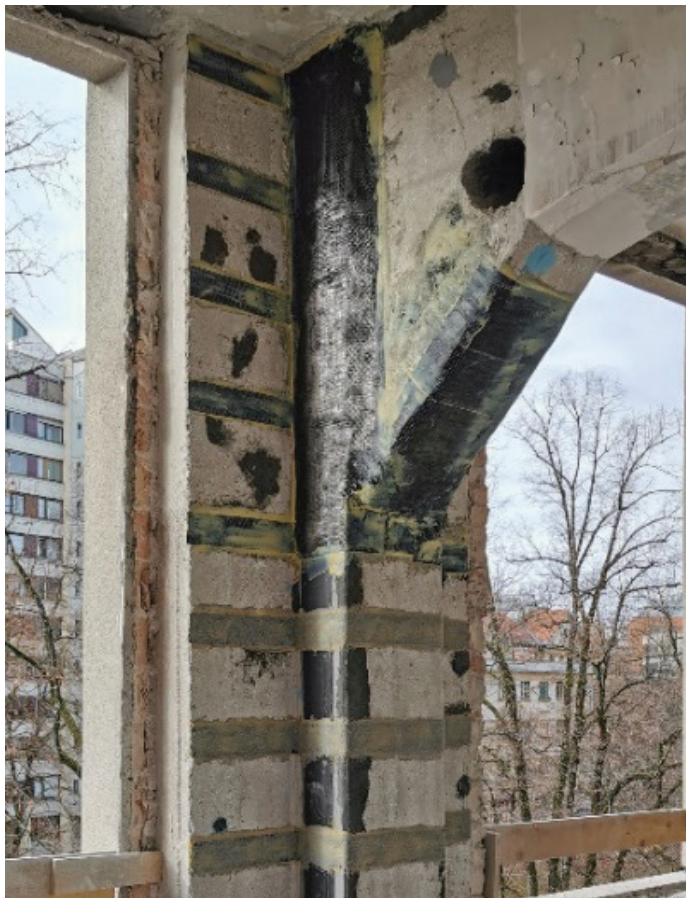
Slika 9. Utrjevanje slopov z lepljenjem karbonskih trakov (foto: arhiv Elea iC, d. o. o.).
