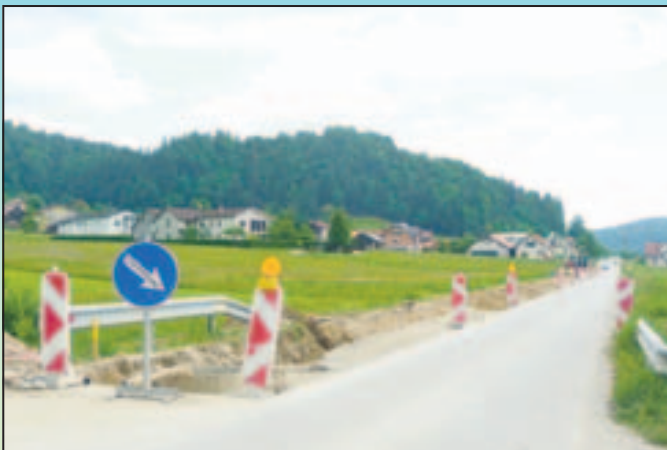
Začetek gradbenih del za gradnjo kanalizacijskega omrežja v Podolnici v začetku maja
