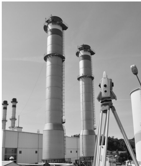
Slika 2: Dimnika plinskih turbin (levo PB5, desno PB4) v Termoelektrarni Brestanica
