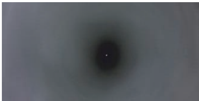
» Pogled v notranost očiščene cevi izmenjevalca toplote. (Vir: Kipp Umwelttechnik GmbH)
