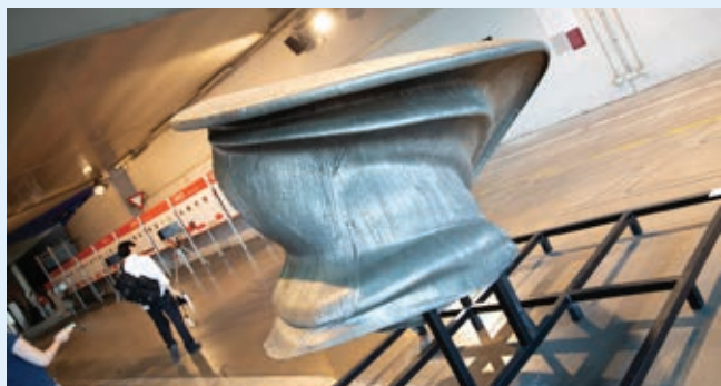
» Razstavljeni detajl 3D-tiskanega mostu na festivalu Ars Electronica (Foto: tom mesic)
