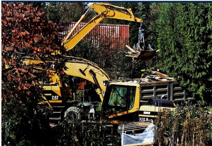
V začetku oktobra so delovni stroji začeli podirati vrtno lope v Črnučah.
