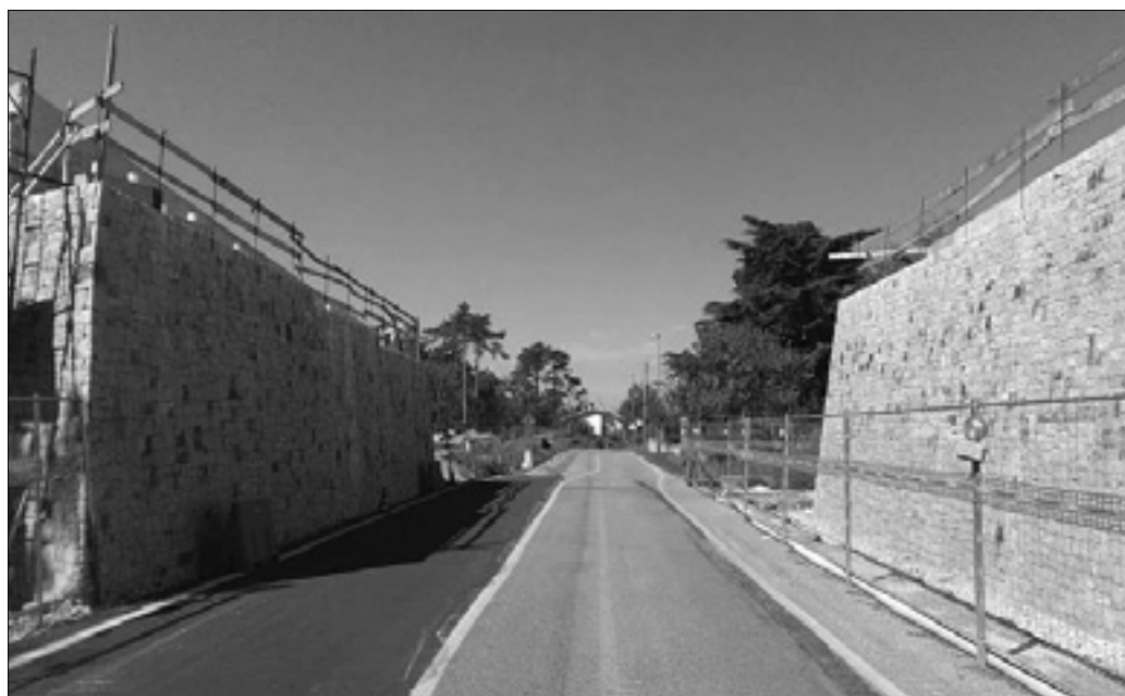
Pogled na oporna zidova ob progi in ob cesti
