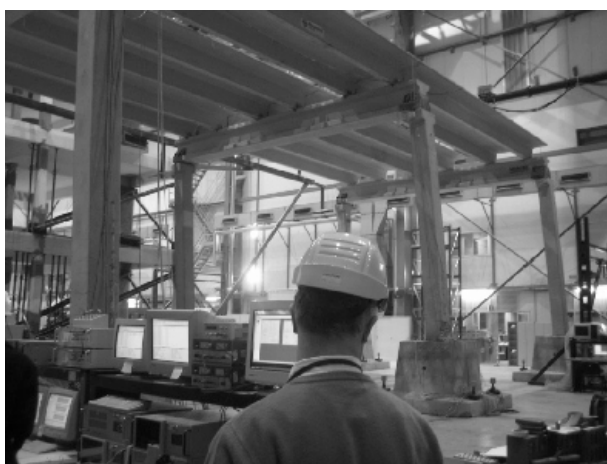
Slika 2.1: Velike relativne rotacije (8 %) med stebri in gredami med psevdodinamičnim preizkusom armiranobetonske montažne hale.
