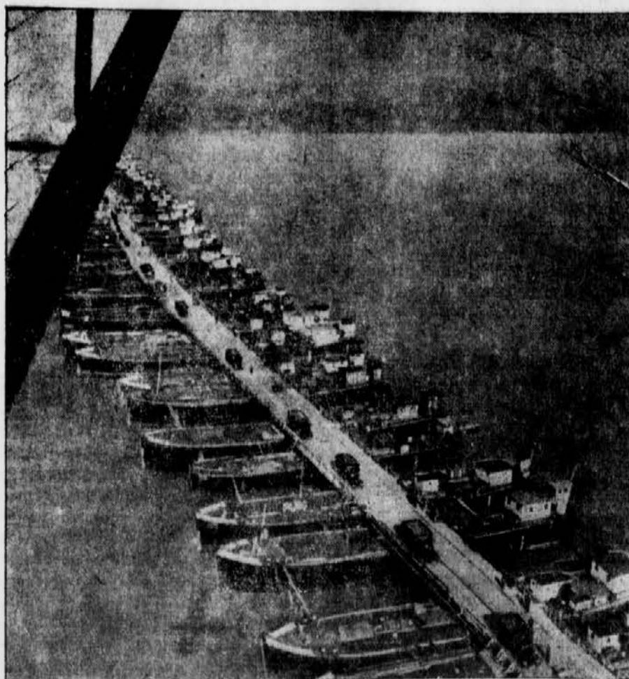
Blick aus dem Flugzeug auf die mächtige Donaubrücke, ein Werk deutscher Pioniere, die das rumänische Ufer mit dem bulgarischen verbindet. Auf breiten Donaukähnen lasten die schweren Bohlen, über die in langer Reihe die Wagen der deutschen Kolonnen rollen.
