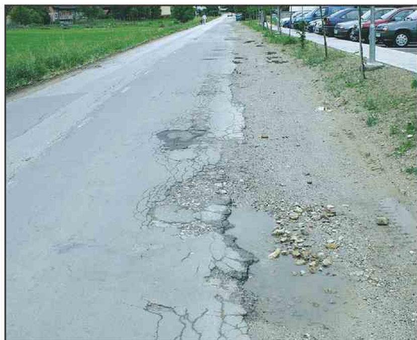
Cesto na Selu, ki je že povsem dotrajana, bodo obnovili po izgradnji novega vodovoda in kanalizacije. Pod njo bodo namreč tudi novi vodi.
