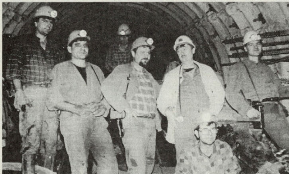
Detajl z delovišča novega črpališča (peti z leve Ivan Pečovnik) - foto I.P.
