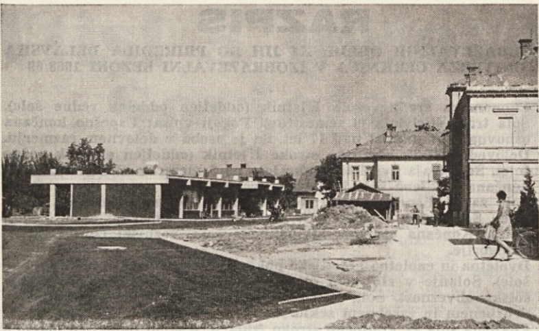
Zaključna dela na novi avtobusni postaji
