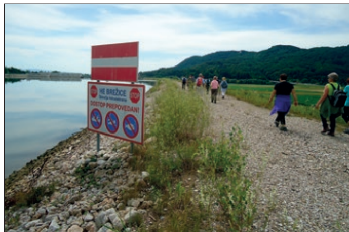
Varovalni nasip pred hidroelektrarno Brežice (Foto: Franc Černelič)
