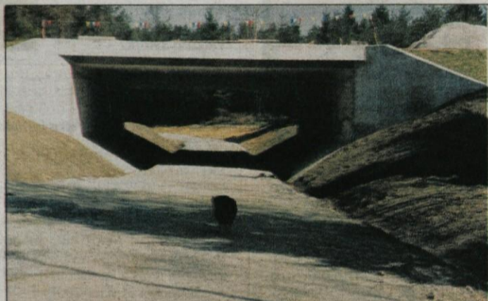
Projektanti in izvajalci, pa seveda predvsem investitorji so poskrbeli tudi za cestne povezave ob avtocesti. Posnetek je nastal v bližini občinskega odlagališča v Dobu - podvoz pa bodo koristili tako ljudje kot živali.
