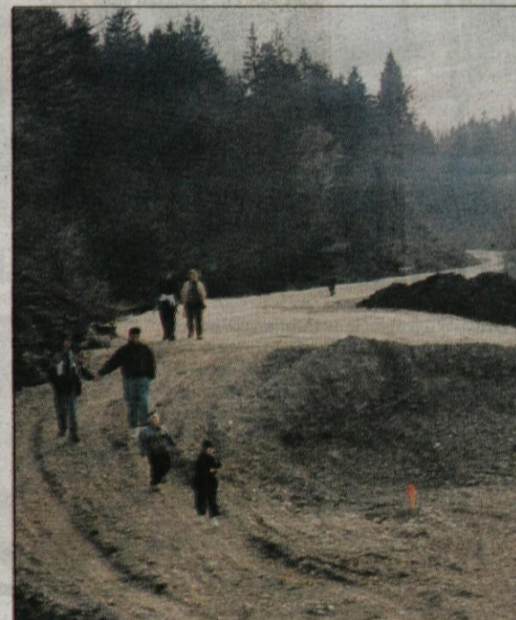
Na fotografiji je odcep obvoznice od spomenika do mostu čez Radomljo, ki je zadnje čase priljubljeno sprehajališče bližnjih krajanov in krajanek.
