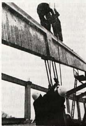
Zahtevno delo pri gradnji skladišča telovadnega orodja
