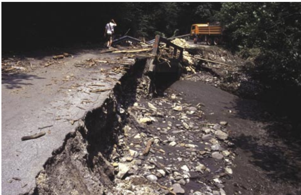
Slika 3: Poplavna voda naredi največ škode v zoženem delu dolin, kjer potekajo drug ob drugem vodotok in komunikacije. Na sliki je poškodovano cestišče v povirju Kotredeščice po hudourniških poplavih poleti leta 1994 (foto: Miha Pavšek).
