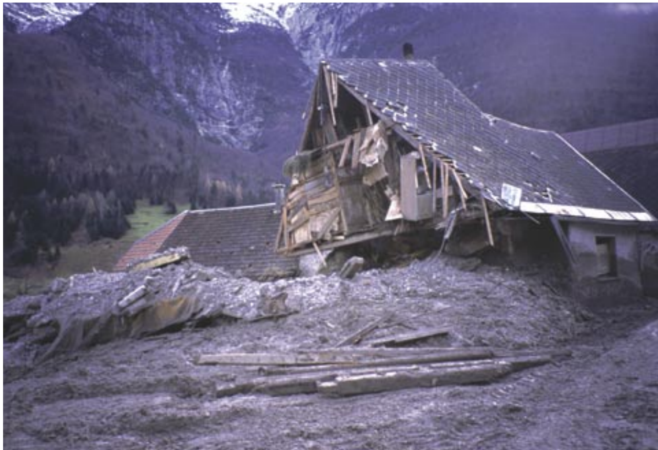
Slika 5: Novembra 2000 je zgornji del Loga pod Mangartom preplaval drobirski tok kot posledica zemeljskega plazu višje zgoraj. Zahteval je sedem življenj, porušil in poškodoval 18 stanovanjskih in 8 gospodarskih objektov ter odložil na površini 15 ha okrog 700.000 m 3 gradiva (foto: Matija Zorn).
