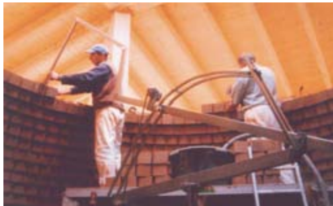
Slika 10: Gradnja kupole iz ilovnatih zidakov s pomočjo rotacijske šablone [Vir: Zogler, 2004:32]. Building a dome with clay bricks by utilising a rotational mould.
