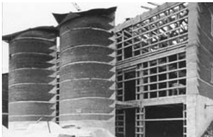
Slika 7: Naselje Domain de la Terre – stopnišča iz butane ilovice [Vir: zur Nieden in Ziegert, 2002: 45]. The settlement Domain de la Terre – packed clay stairways.
