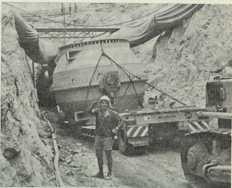
Transport krogličnega zasuna v dostopni predor. Predor je bil komajda dovolj velik za tolikšen tovor.
