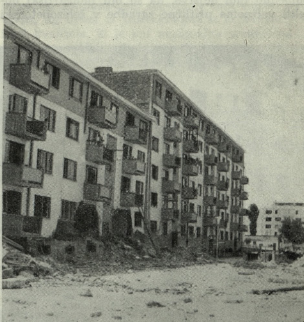
Stiri zgornje etaže so se usedle na porušeni spodnji dve etaži
