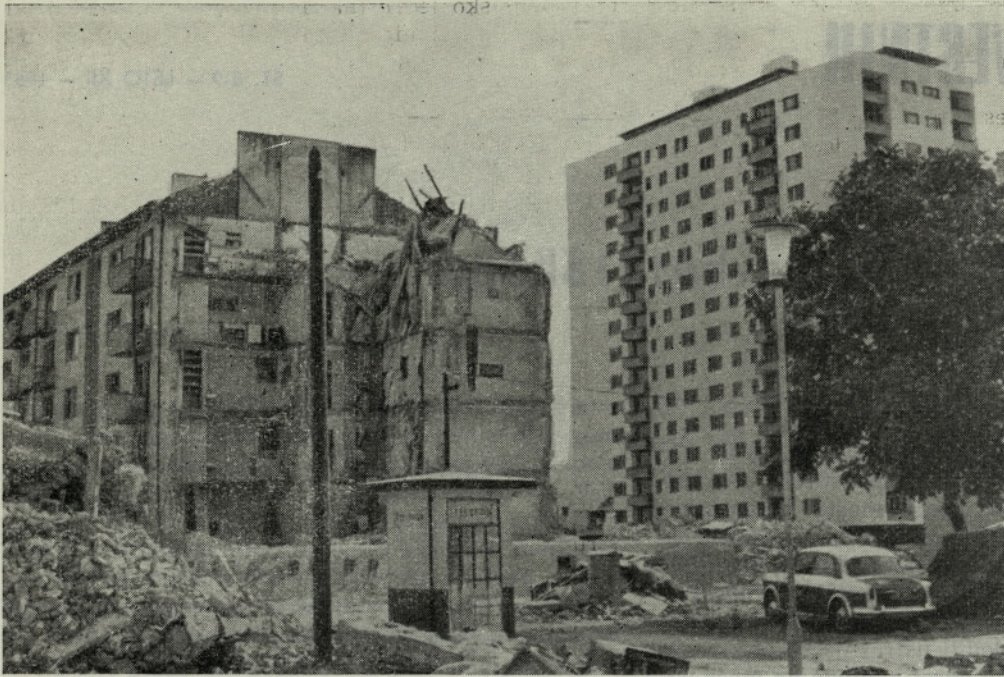
Značilni učinek potresa. Ohranjena železobetonska skeletna konstrukcija in porušena zidana stavba
