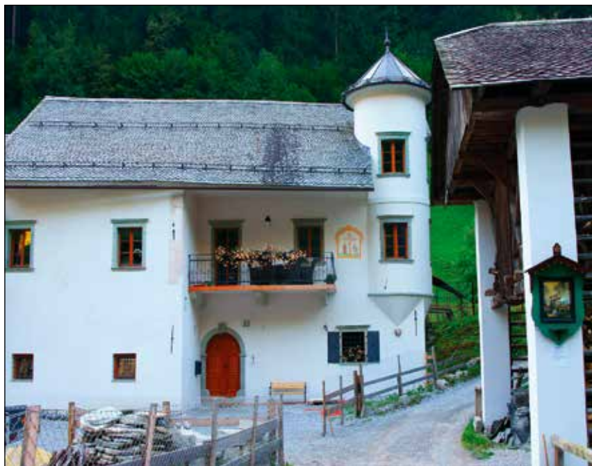
Plnada po obnovi.
