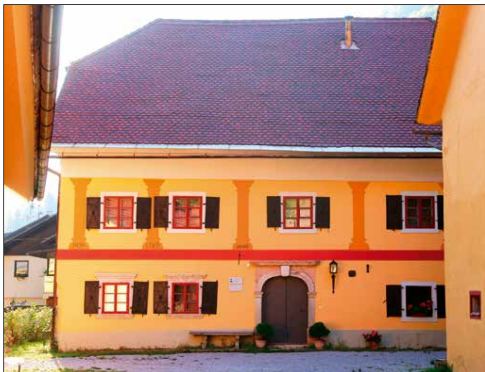
Jegličeva hiša po obnovi.
