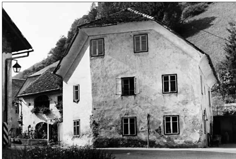
Na plavžu 34 pred obnovo.
