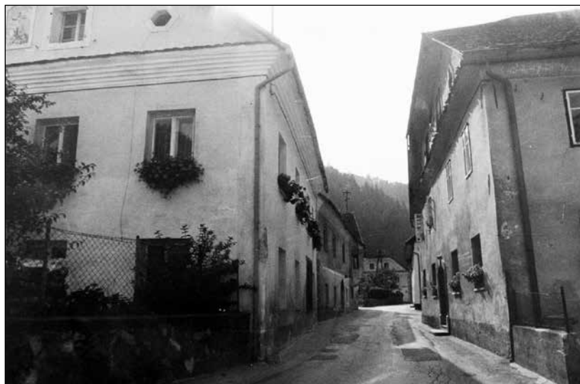
Na plavžu 37 in 38 pred obnovo.
