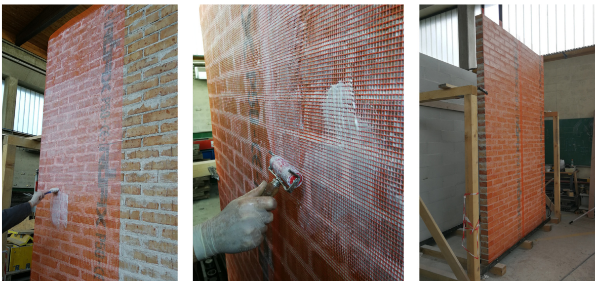
Slika 5.8: Izvedba utrditve preizkušanca nekonstrukcijskih zidov s sistemom B.
