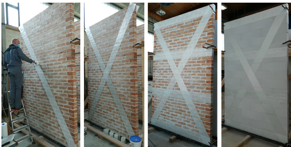
Slika 5.13: Izvedba utrditve preizkušancev nekonstrukcijskih zidov s sistemom D. Figure 5.13: Strengthening of non-structural wall specimen with system D.
