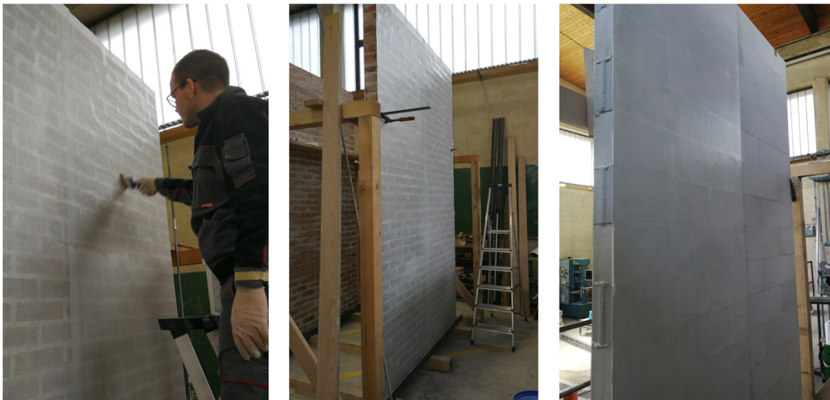
Slika 5.7: Izvedba utrditve preizkušanca nekonstrukcijskih zidov s sistemom A.
