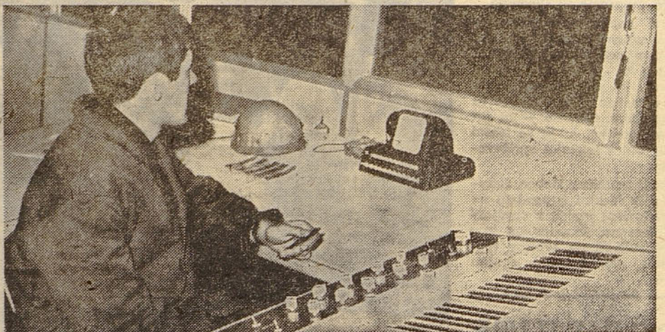
Tehnolog dispečerskega centra inž. Vladimir Senčar, ki upravlja začasno našo napravo za signalizacijo v valjarni jeseniške železarne
