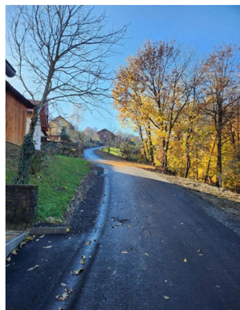
Obnova ceste Hrastovec–Juršak
