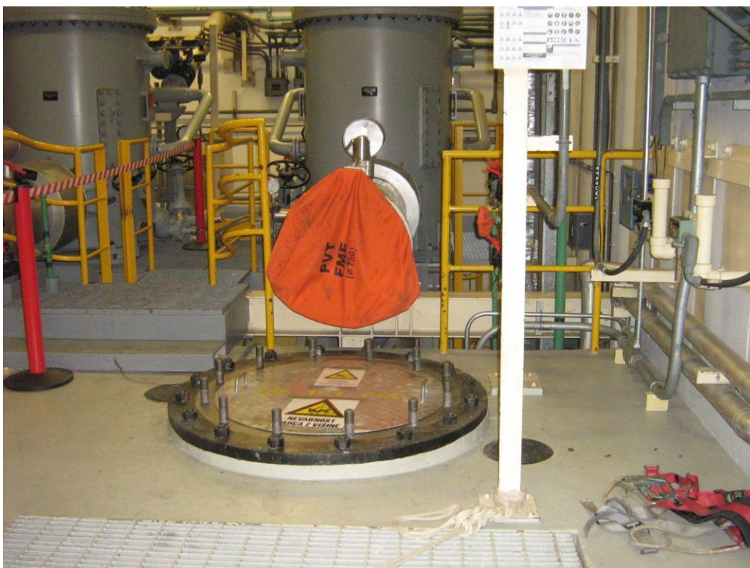
Slika 72: Temelj SW črpalke B (Foto: inšpekcija URSJV)
