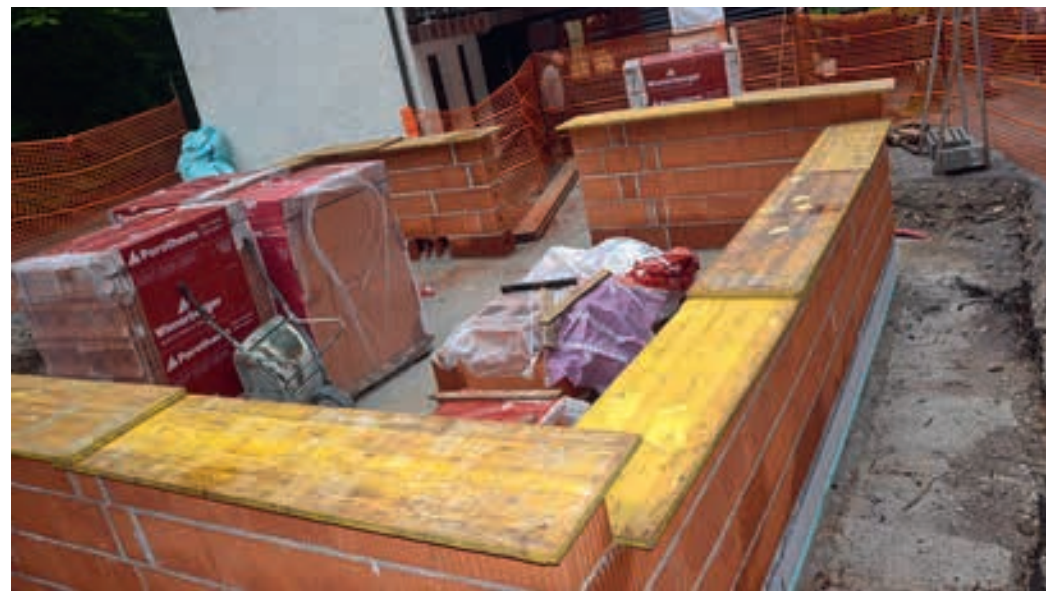
Dela za prenovo kuhinje že potekajo.
