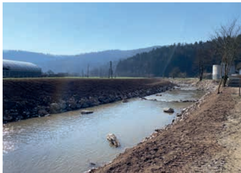
Izvedene vodnogospodarske ureditve ob čistilni napravi – zavarovanje iz razgibane kamnite zložbe, sidrane z lesenimi piloti, visokovodni nasip in ribja skrivališča.
