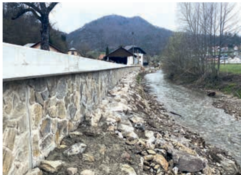
Nadvišanje in sanacija obstoječega zidu ter izgradnja dodatnega zidu ob Mali vodi z izvedenim robnim vencem.
