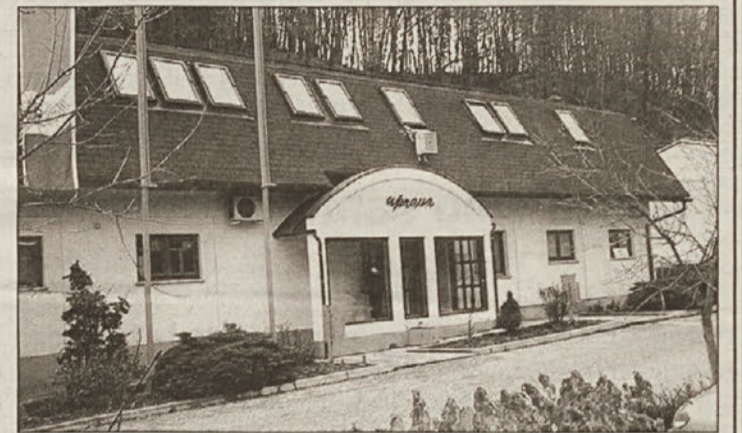
Upravna zgradba podjetja v Krškem
