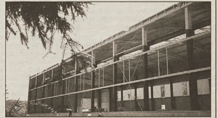
Takole je bilo na gradbišču sredi marca.
