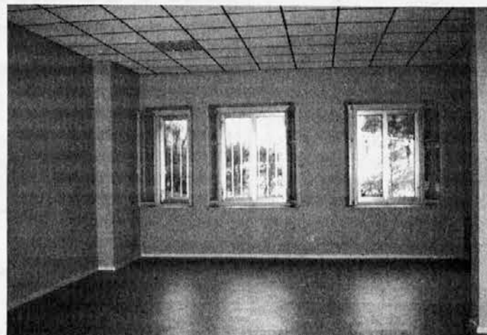
L'interno della scuola di Clodig, da poco ristrutturata
