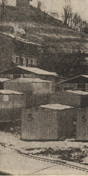
Pogled na pločevinaste barake v Brezju s porušeno vasjo v ozadju (foto Tavčar)
