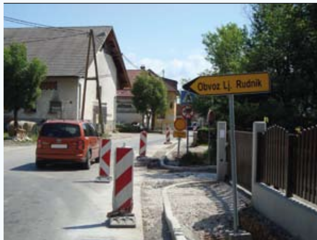
V središču Iga poteka izgradnja manjkajočih delov pločnika ob Ljubljanski cesti.
