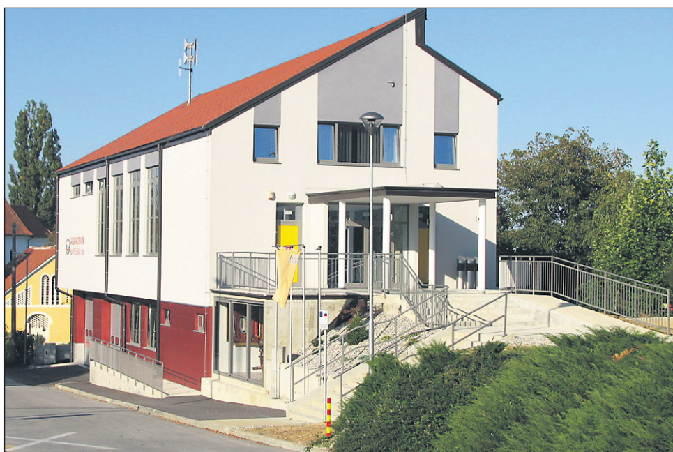
Za poplačilo računov izgradnje novega vaško-gasilskega doma na Polenšaku (na posnetku) je občina najela kratkoročni kredit, ki ga bo poplačala do konca leta.
