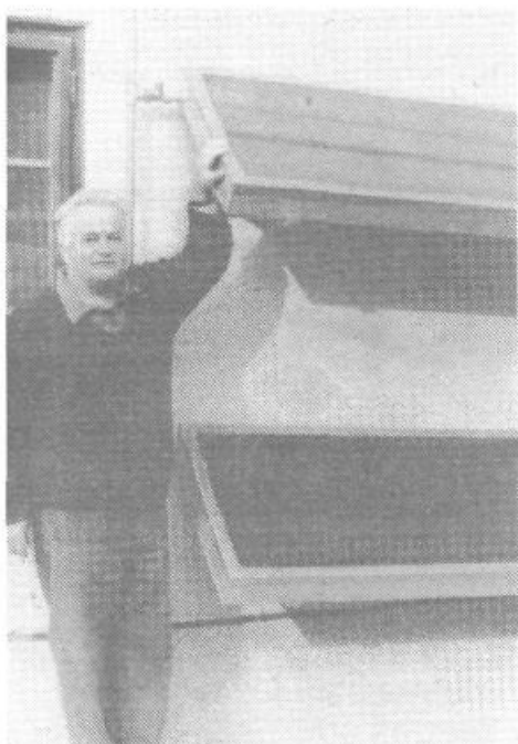
Sonce postaja vse dragocenejši vir energije. Iznajdljivi Rudolf Sečnik si je omislil sončni kolektor kar takole ob zidu in sploh ne potrebuje črpalke.
