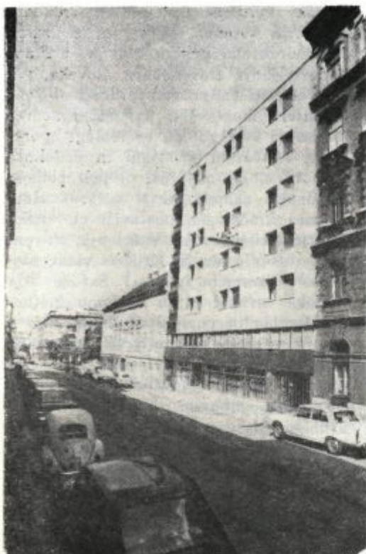
Slovenski visokošolski dom „Korotan“ na Dunaju — pročelje šestnadstropne stavbe
