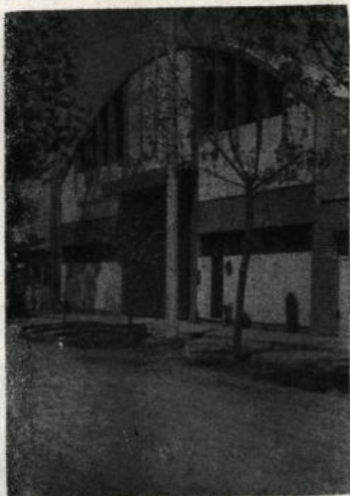
Pročelje Bajdovih sodarskih in parketnih delavnic
