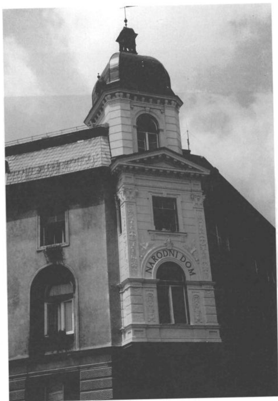
Slika 10: Rekonstruiran vogalni del s fasadnim pomolom in strešnim stolpičem. (Fotografija Bogdan Badovinac, ZVNKD Celje, 1989.)
