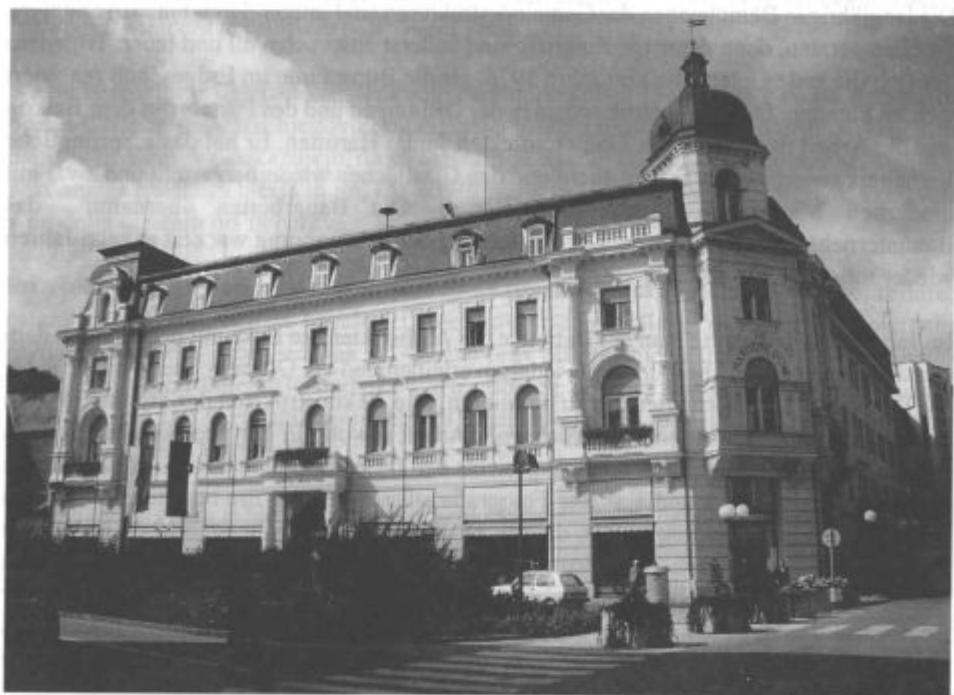
Slika 11: Zunanjščina Narodnega doma po končani prenovi. (Fotografija Bogdan Badovinac, ZVNKD Celje, 1991.)
