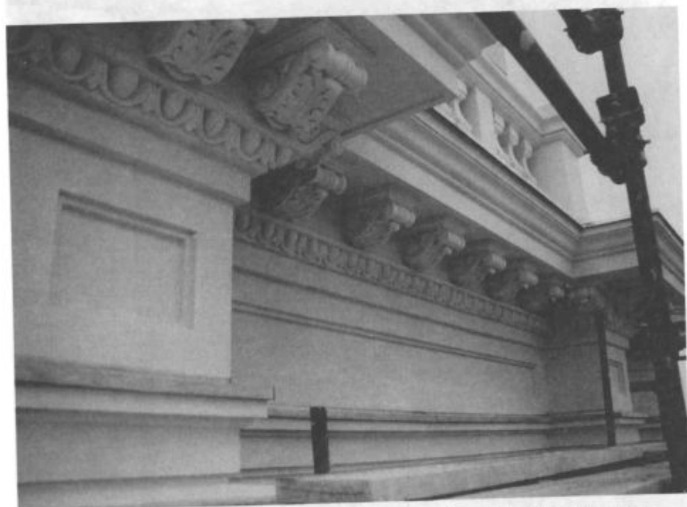
Slika 8: S konzolami in jajčnim nizom okrašen strešni zidec rizalita. (Avtor fotografije Bogdan Badovinac, ZVNKD Celje, 1991.)
