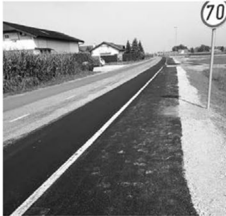
Pločnik je bil asfaltiran konec avgusta.
