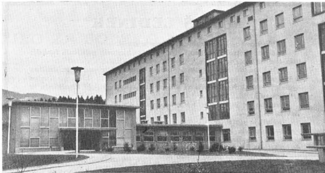
Delovno ljudstvo je s skupnimi napori zgradilo nov kirurško ginekološki blok bolnišnice v Slovenskem Gradcu. Zgradbo so ob navzočnosti visokih gostov svečano odprli 9. maja 1964.
