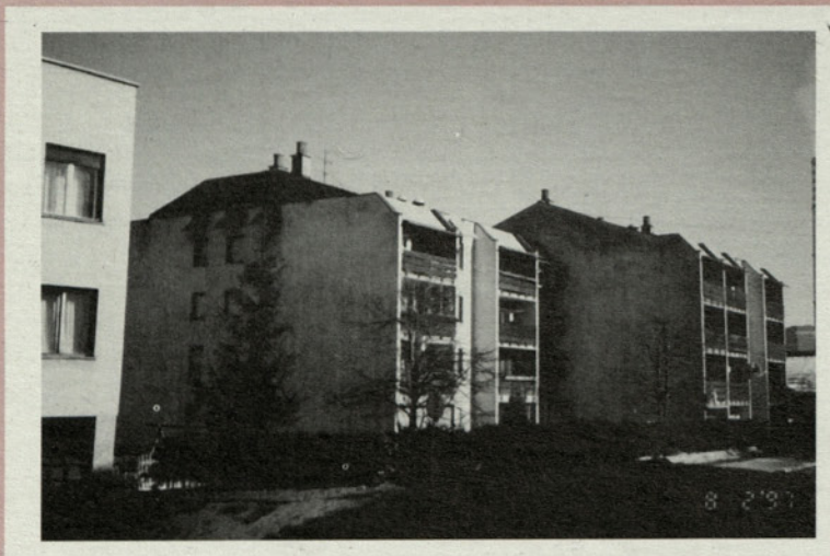
Okorni poskus kako zaključiti streho na stavbi ob Levstikovi.
