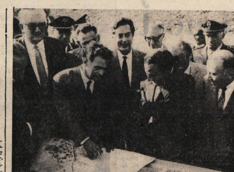
Minister Misasi in U. Agnelli sta si večeraj v spremstvu predstavnikov oblasti ogledala gradbišče za Grandi Motori pri Boljuncu. Tehnične značilnosti nove pobeude sta gostom razložila predsednik družbe ing. Vignuzzi in podravatelj ing. Di Stefano. — Gradbišče se razprostira na površini 640.000 kv. metrov, za uravnavo zemljišča pa bodo izkopali vsega 3.300.000 kub. m zemlje. Dostoj. do od tega izkopali že 2.800.000 kubikov zemlje, položili prve temeljne elemente za tovarno ter začeli notranje in dovzno cesto. Minister Misasi je izrazil svoje zadovoljstvo s pričo pomembnosti pobeude in napredka, ki je bil dosežen na poti njene uresnitve. Med svojim bivanjem v našem mestu se je minister sestel z najvišjimi zastopniki pokrajinskega vodstva Krščanske demokracije v palači Diana. Ti so mu predložili zlasti znane probleme v zvezi s poslovanjem pristanišča
