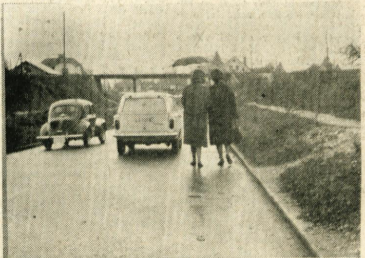
Lepo in solidno zgrajeno Kamniško cesto močno kazi neurejen podvoz. Pešči morajo zaradi neurejenih pločnikov hoditi po cestišču, namenjenem za motorna vozila in se tako izpostavljati stalni nevarnosti. Ali ni bil izvajalec del dolžan, dokončati tudi ta del ceste v celoti? Pločniki so prav tu, zaradi ozke ceste res potrebni
