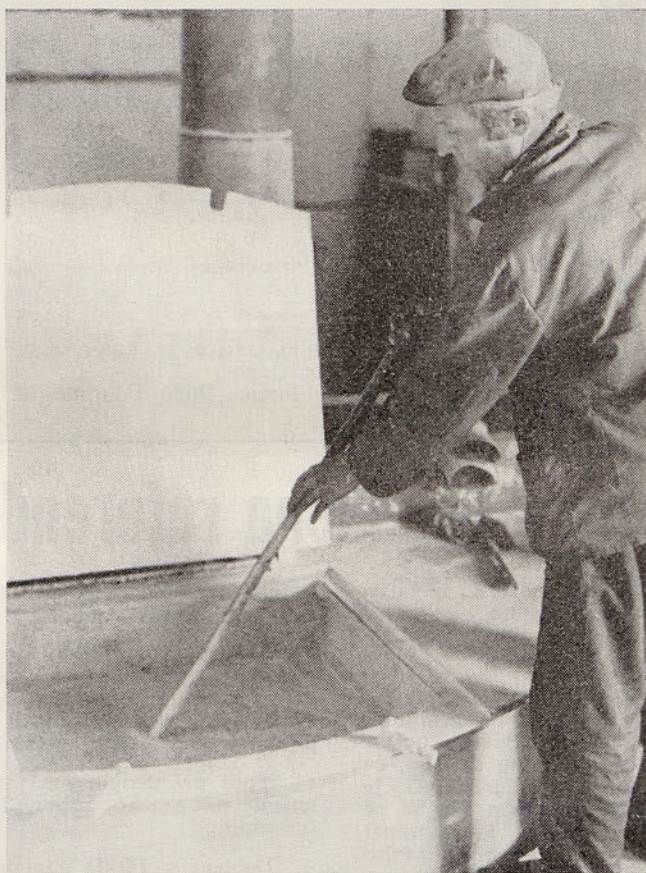
Priprava apna v omehčevalnici vode
