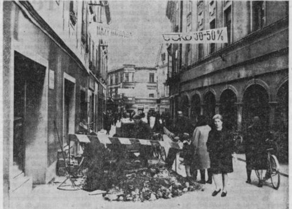
Prešernova ulica ima letos prav gotovo svojstven rekord v številu dni, ko je vsaj delno razkopana. Ni minilo več kot bore nekaj tednov, ko so izravnavali cesto vsled nove kanalizacije že jo zopet razkopavajo ...
