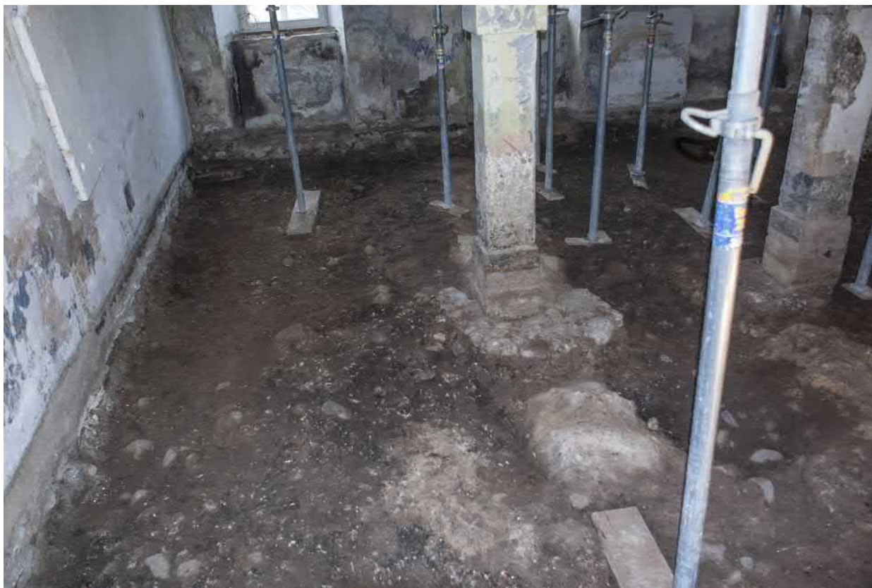
Slika 3.2 V notranjosti Lovskega dvorca je dodatne nevspečnosti povzročalo podporje, ki je preprečevalo porušenje obokanih stropov (foto P. Janežič).
