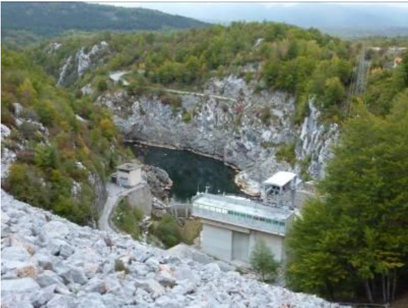
Slika 6: Višina pregrade znaša 81 m in ob njenem vznožju se nahaja HE Sklope. Po iztoku iz te HE se za povezovalnim tunelom Lika – Gacka vode obeh rek združijo in se iz manjše akumulacije Gusić polje usmerijo proti HE Senj (cca 400 m padca). V načrtu je nadgradnja sistema z dodatno dolvodno akumulacijo Kosinj, ki bi bila locirana na Lipovem polju (?). Po ogledu pregrade nas je zajela noč in ob prehodu na morsko stran Velebita še močna burja. Precej izdelani smo menda okrog 22h prispeli v Starigrad. Hrana. Pivo. Postelja.
