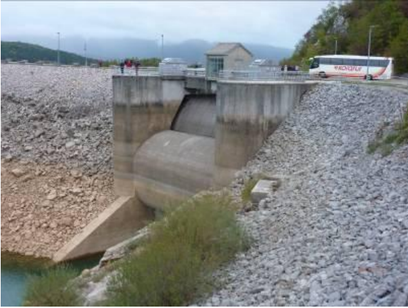
Slika 5: Po kosilu na Vrelu Gacke smo se po vedno slabšem vremenu in po vedno slabših cestah odpravili proti tretjemu cilju – pregradi Sklope. Pregrada, ki ustvarja jezero Kruščica, ima zanimivo zgodovino, saj je bila zamišljena kot ločna, vendar se je o izvedbi pokazalo, da je geologija povsem neustrezna, predvsem kavernozna. Zato je bila izvedena nasuta skalometna pregrada s poševnim glinenim jedrom.
