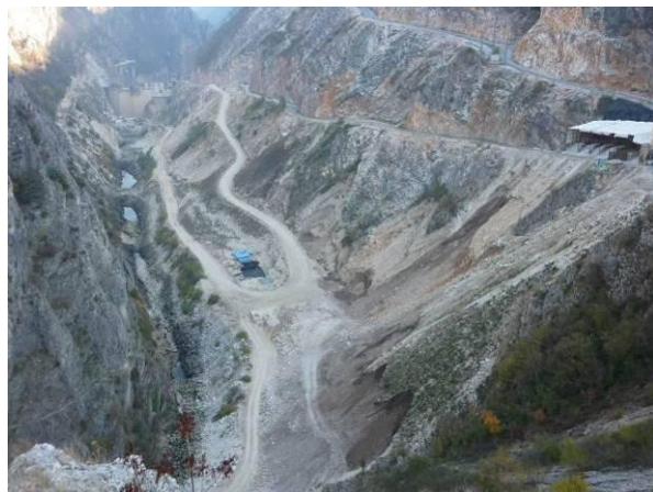
Slika 8: Dolina gorvodno od pregrade je divja in v veliki meri že preoblikovana zaradi dostopne ceste, kar je predstavljalo tudi problem ob zapiranju gradbene jame. V poletnem času se izredno segreje (menda tudi do 50^\circ ), v zimskem pa vanjo nekaj mesecev sonce sploh ne posije. Kljub temu je v dno in na pobočja postavljena vsa potrebna infrastruktura gradbišča, celo kapelica.
