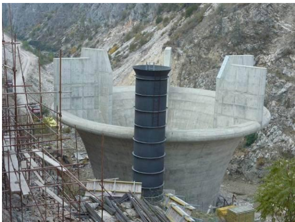
Slika 6: Visokovodni preliv je jaškast, njegova kapaciteta je 1200 \text{ m}^3/\text{s} . Jašek je priključen na obtočni rov, ki se v času gradnje uporablja za evakuacijo visokih vod. Po zaključku gradnje se bo začasni vtok v rov zaprl s plombo. Na sliki je ustje preliva z ozračevalno cevjo.
