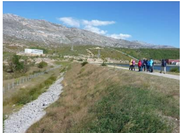
Slika 8: Spodnji bazen ČHE Velebit se imenuje Razovac, na sliki je istoimenska pregrada. Na zgornjem horizontu sta še bazena Štikada in dodatno manjše Opsenica. Padec znaša 550 m, inštalirani pretok turbinskega načina pa 60 \text{ m}^3/\text{s} . Letna proizvodnja znaša 430 GWh.
