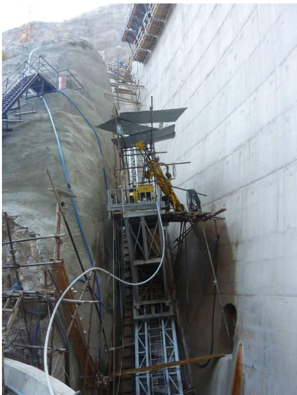
Slika 5: Pregrada nima injekcijske galerije, tesnitev se izvaja s posebnimi progami z zunanje strani. V dnu doline je zavesa globoka 50 m, v bokih pa 75 m. Na sliki je proga za tesnitev desnega boka, vidna je vrtna garnitura.
