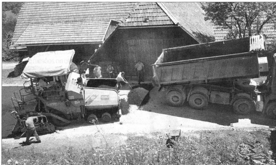
Asfaltiranje na lokalni cesti v Primožu (foto: Marija Lebar)
