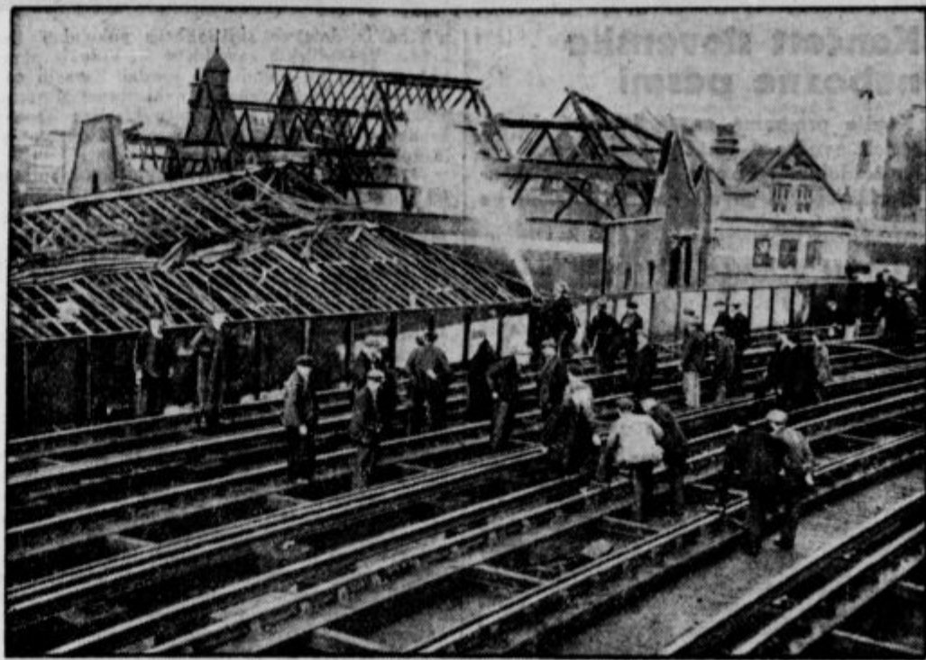
Pogled na pogorelo londonsko tržnico. Delavci v ospredju s vso naglico popravljajo razrito progo.
