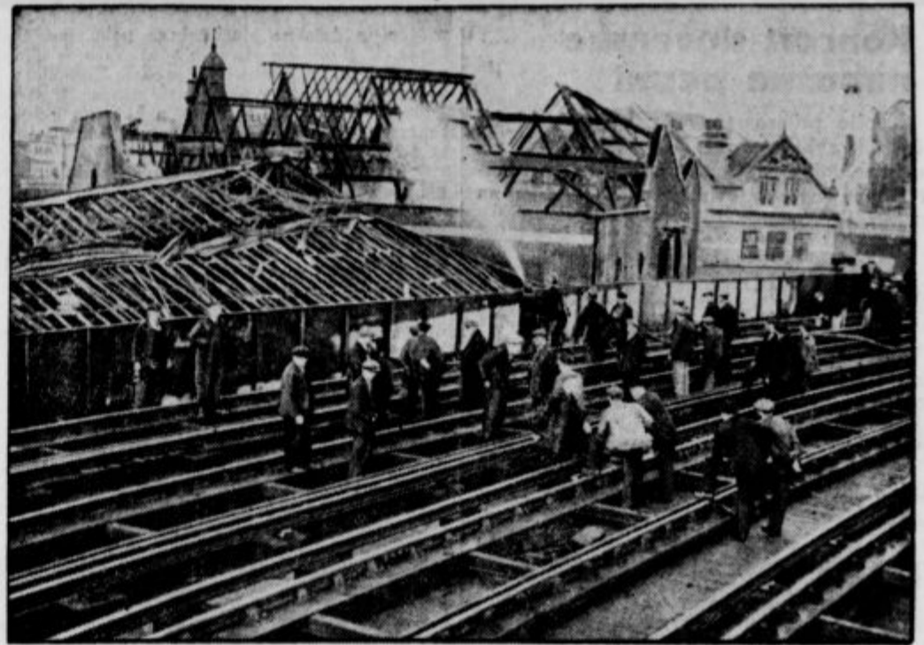
Pogled na pogorelo londonsko tržnico. Delavci v ospredju z vso naglico popravljajo razrito progno.
