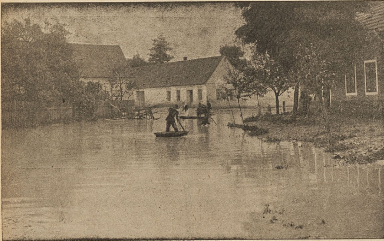
Strašne povodnji na Ogrskem: Poplavljená cesta v Seredu.
