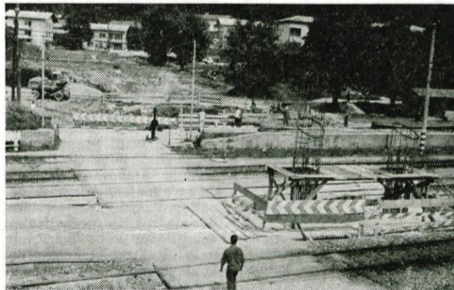
Gradnja nadvoza napreduje. Foto: Zofka
