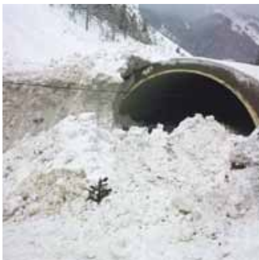
Plaz z Begunjščice je zasul cesto pred galerijo pod Ljubeljem
