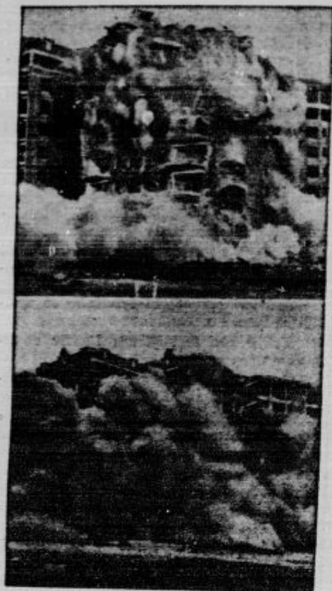
V Ameriki podirajo hiše z dinamitom. V Washingtonu so razstrelili celo vrsto hiš, da so dobili prostor za velikansko stavbo vojnega ministrstva.
